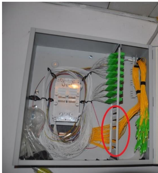
Rys.1. Wolne pola na ODF mogące pełnić funkcję pól parkingowych dla wtyków multipaczorku PT
